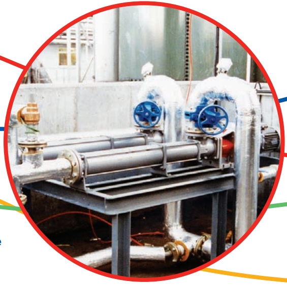
Bombeo de mezcla de lechadas
